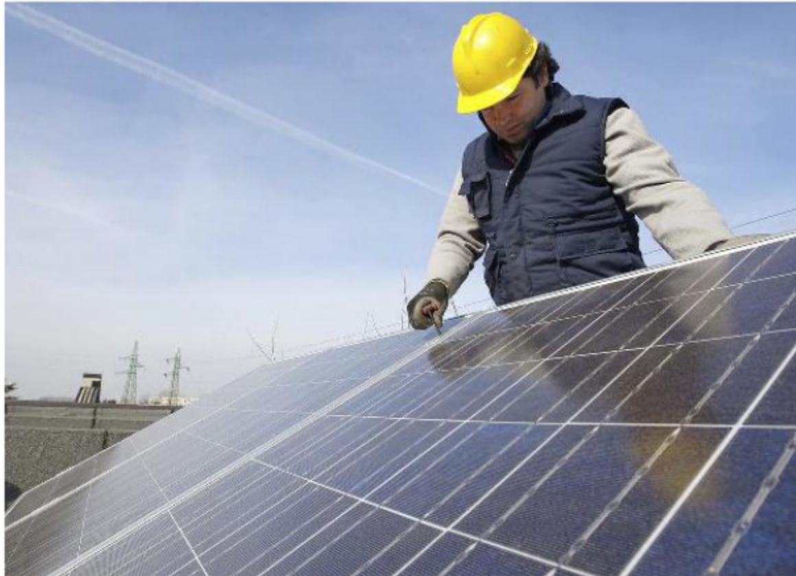
Un'installazione di un pannello solare in cima ad un edificio
